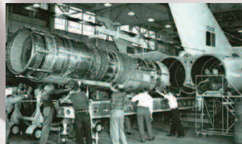
Montaż pierwszego silnika Iroquois do Avro Arrow
