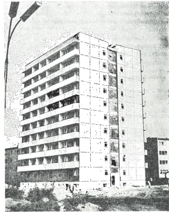
Rys. 5. Wielkopłytowy budynek 10-kondygnacyjny na osiedlu Koło, ul. Górczewska w Warszawie.
